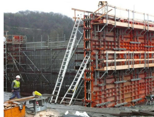
Bekisting laten staan
