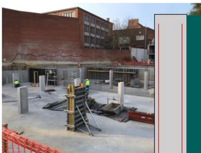
Kelderwanden tegen soilmix Lente 2021
