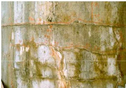
Réaction sulfatique interne
