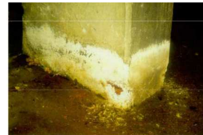
Réaction sulfatique externe
