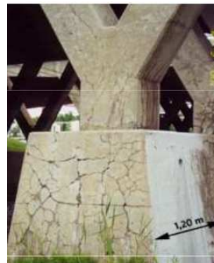
Réaction alcali-silice
