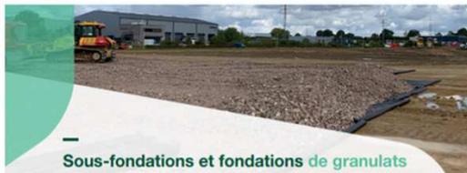
Sous-fondations et fondations de granulats recyclés mixtes pour bâtiments industriels
