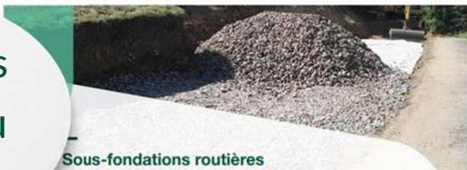
Sous-fondations routières en granulats recyclés de béton
